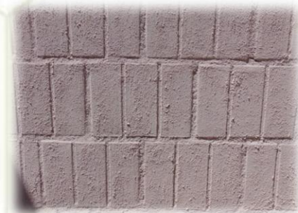
Ladrillo c/pintura grano
