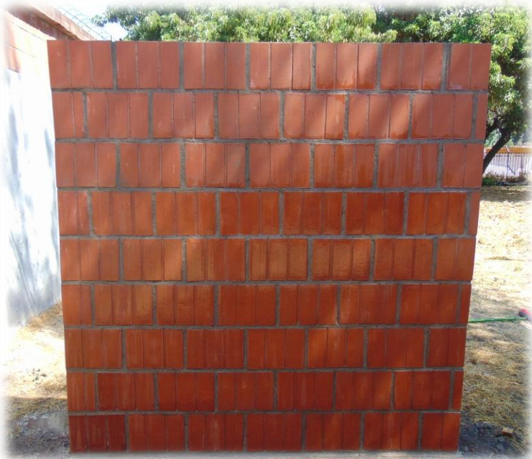
Ladrillo a la vista sin ranuras rellenas con mortero
