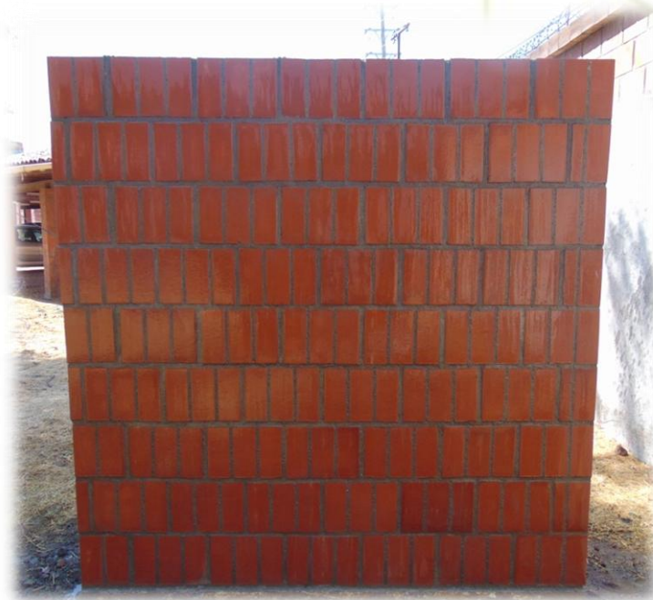
Ladrillo a la vista con ranuras rellenas con mortero
